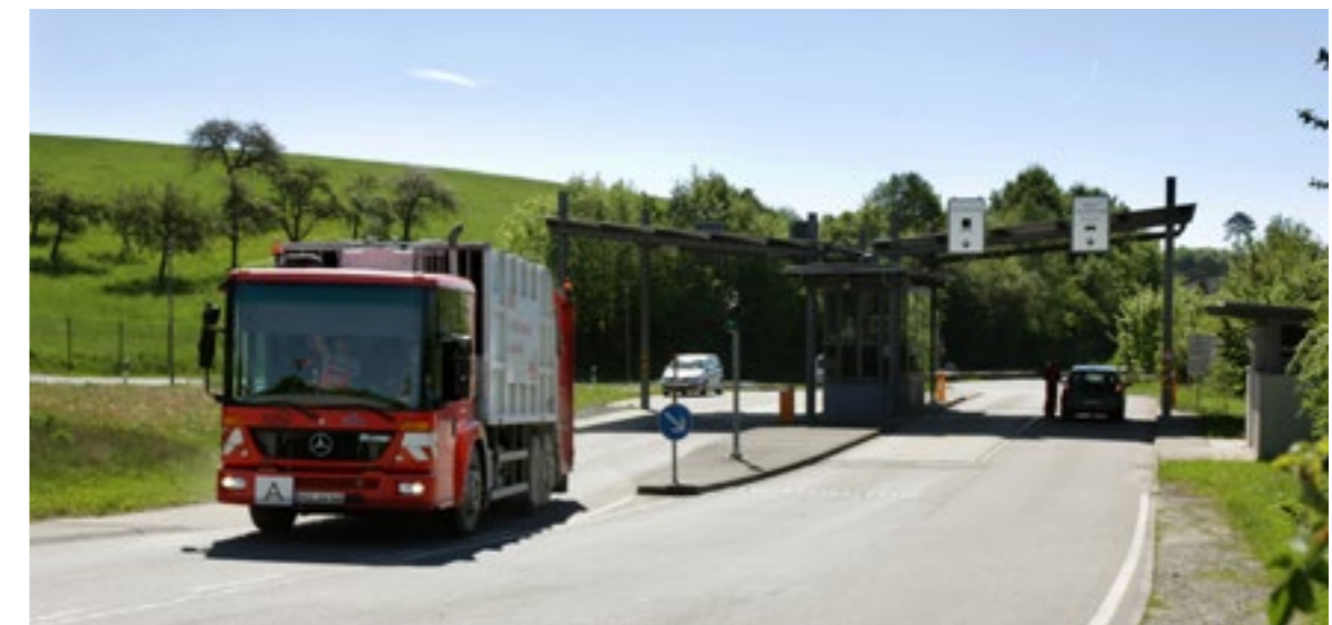
Inbetriebnahme des neuen Wiegeterminals am Standort „Sansenhecken“ mit getrennter Ein- und Ausgangswaage.
