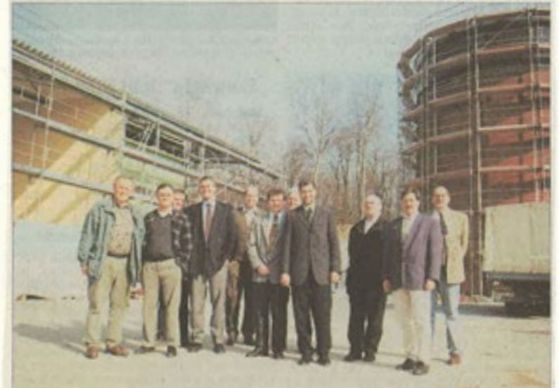
Nach Plan läuft die Errichtung der mechanisch-biologischen Restmüllbehandlungsanlage im Entsorgungszentrum Sansenhecken. Davon überzeugte sich der Ausschussrat der AWN. Von links nach rechts: Wilhelm Ehret, Klaus-Dieter Heiser, technischer Deponieleiter Hubert Kleser, AWN-Geschäftsführer Dr. Mathias Ginter, Deponieleiter Rainer Dietz, Bürgermeister Dr. Achim Brötel, Odo Brommer, Landrat Detlef Piepenburg, Werner Schirmer, Karlheinz Graner, Rainer Schäfer
