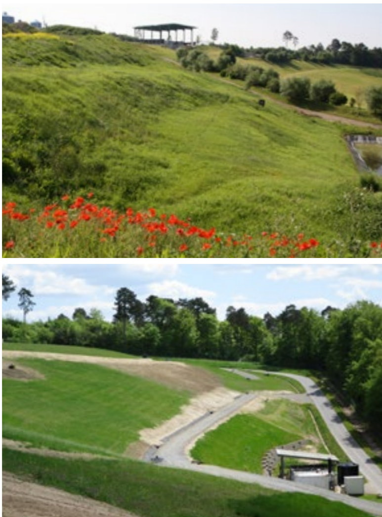
Vorderer Deponiebereich vor und nach der Maßnahme zur Oberflächenabdichtung, noch ohne Bepflanzung.
